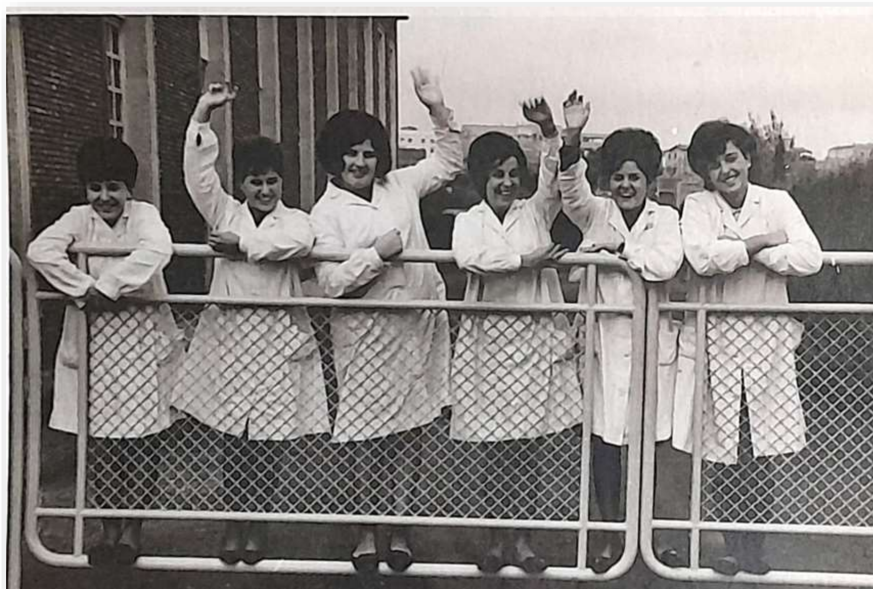
Grup de treballadors dels laboratoris ROCADOR. Cessió Maria Lluïsa Sanz.
