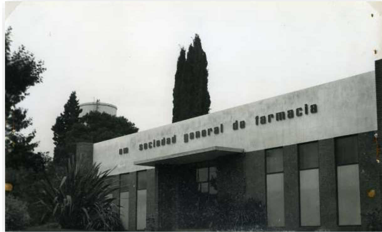
Façana principal Laboratoris SOGEFA. Data 1964
