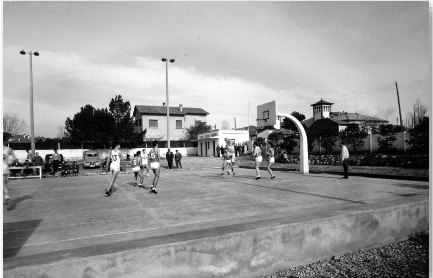
Pista construïda per l'empresa Carlo Erba., podria a ver estat ubicada al carrer Eduard Toldrà. Data [1950-1965]
