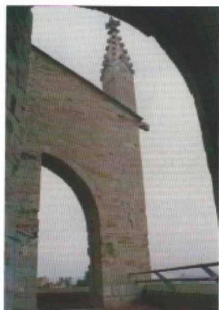
Contrafort amb arcbotant i pinacle gòtic
