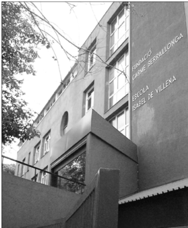
Vista de la façana d'aquesta escola
